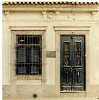
Fachada da casa no 13 da Rua do Chichorro, bairro do Catumbi, na cidade do Rio de Janeiro onde foi criado, no dia 14 de junho de 1910, o Centro de Boys Scouts do Brasil.
